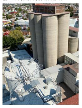
即便将刚刚送达的谷物从筒仓上方注入筒仓中的过程长达数分钟,VEGA传感器也能不受影响地测量正在接受装料的筒仓。即使细粉尘长时间附着在仪表上,测量也不会受到影响。此类仪表免维护,既不需要专门清洁它们,也不需要对它们采取特殊的防尘措施。通常,在此类瘦高型筒仓中的内装件和撑杆在测量时也会引起问题。
