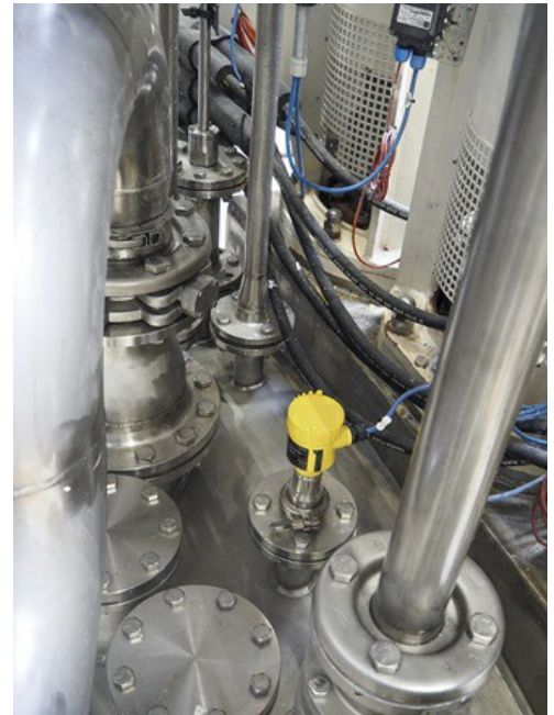
Das Radarfüllstandmessgerät VEGAPULS 64 misst zuverlässig den Füllstand in den Produktionsanlagen.
