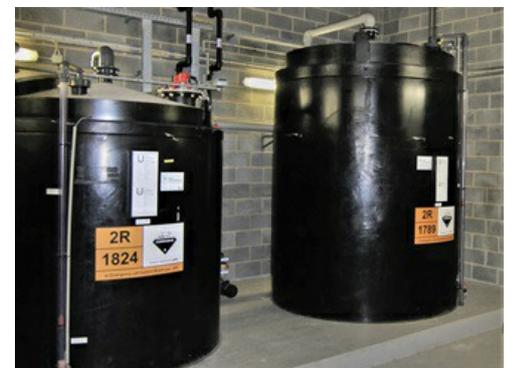
Chemikalienbehälter für die Säure- und Laugenlagerung.
