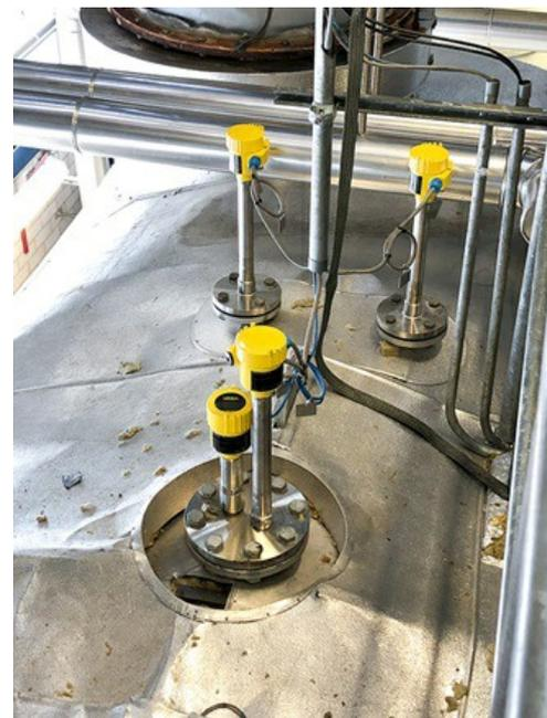
Die redundante Messung sorgt dafür, dass das Wasserniveau im optimalen Bereich arbeitet.
