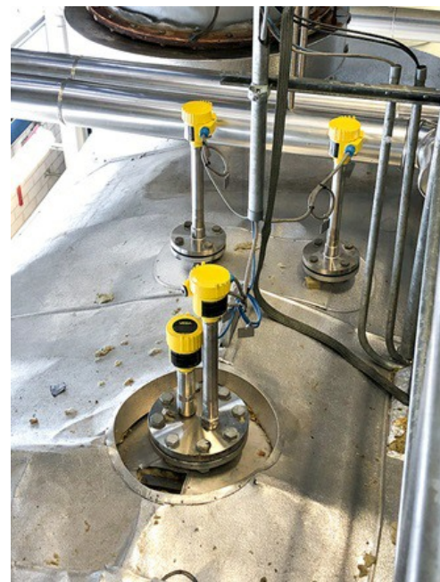
La mesure redondante garantit un niveau d'eau optimal.
