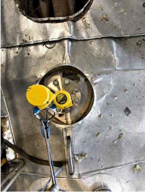
两台测量变送器在组合法兰上相互确认其测量结果的可信度。
