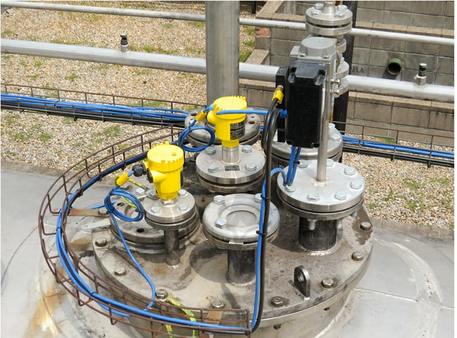
Der enge Radarstrahl des Füllstandsensors erlaubt die Montage auch dort, wo metallische Elemente vorkommen.
