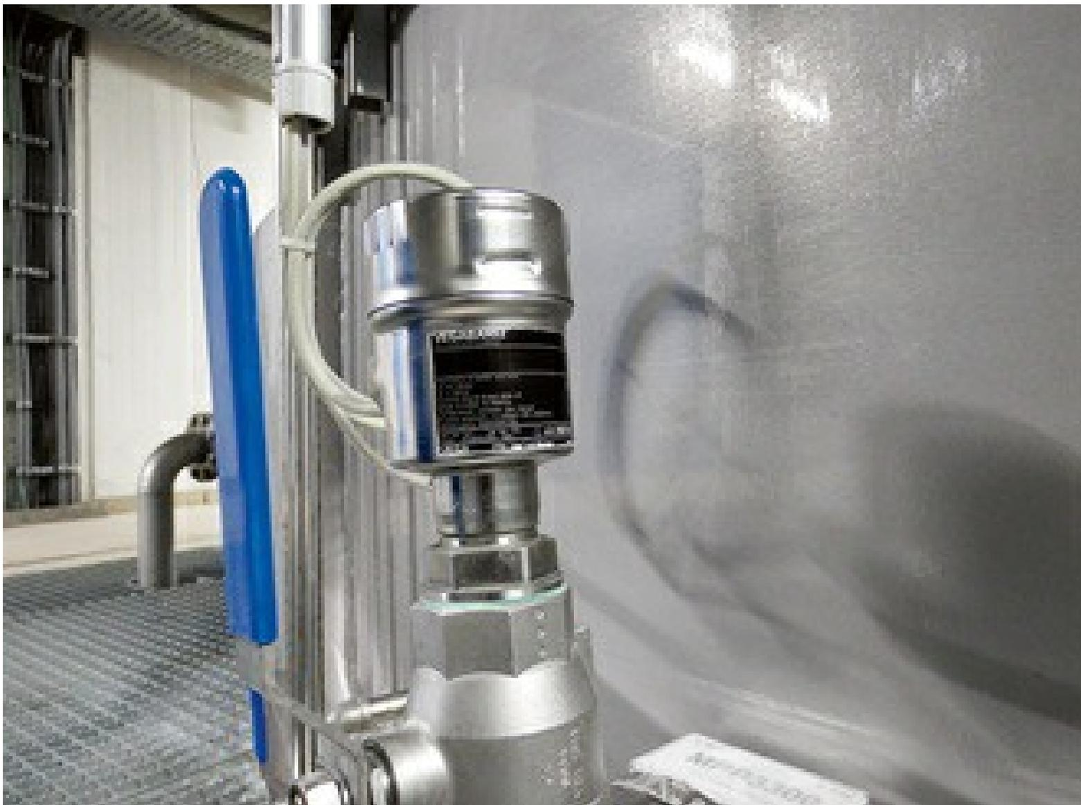
Point de mesure avec VEGABAR 82 et Second Line of defense.
