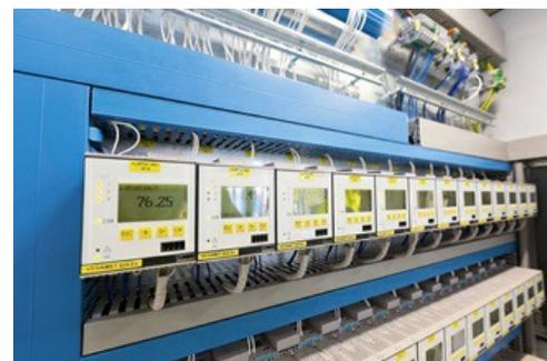
Armoire de commande avec les transmetteurs VEGAMET 624 pour le stockage souterrain de solvants.
