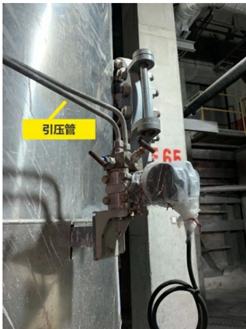
改造前：采用引压管加传统差压液位计
