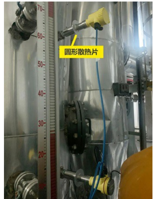
改造后：拆除引压管直接安装在槽壁
