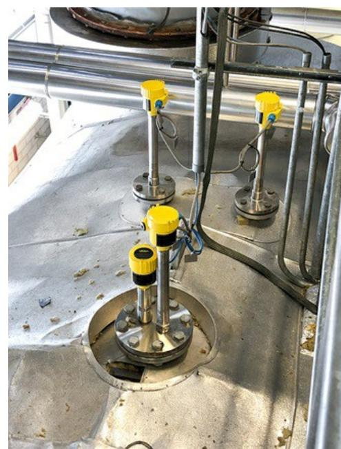
La medición redundante garantiza que el nivel del agua permanezca dentro del rango óptimo.
