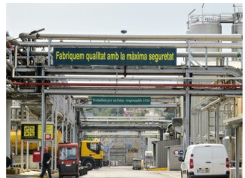
Die Werksanlagen der Croda Ibérica SA am Standort Fogars de la Selva (Barcelona).
