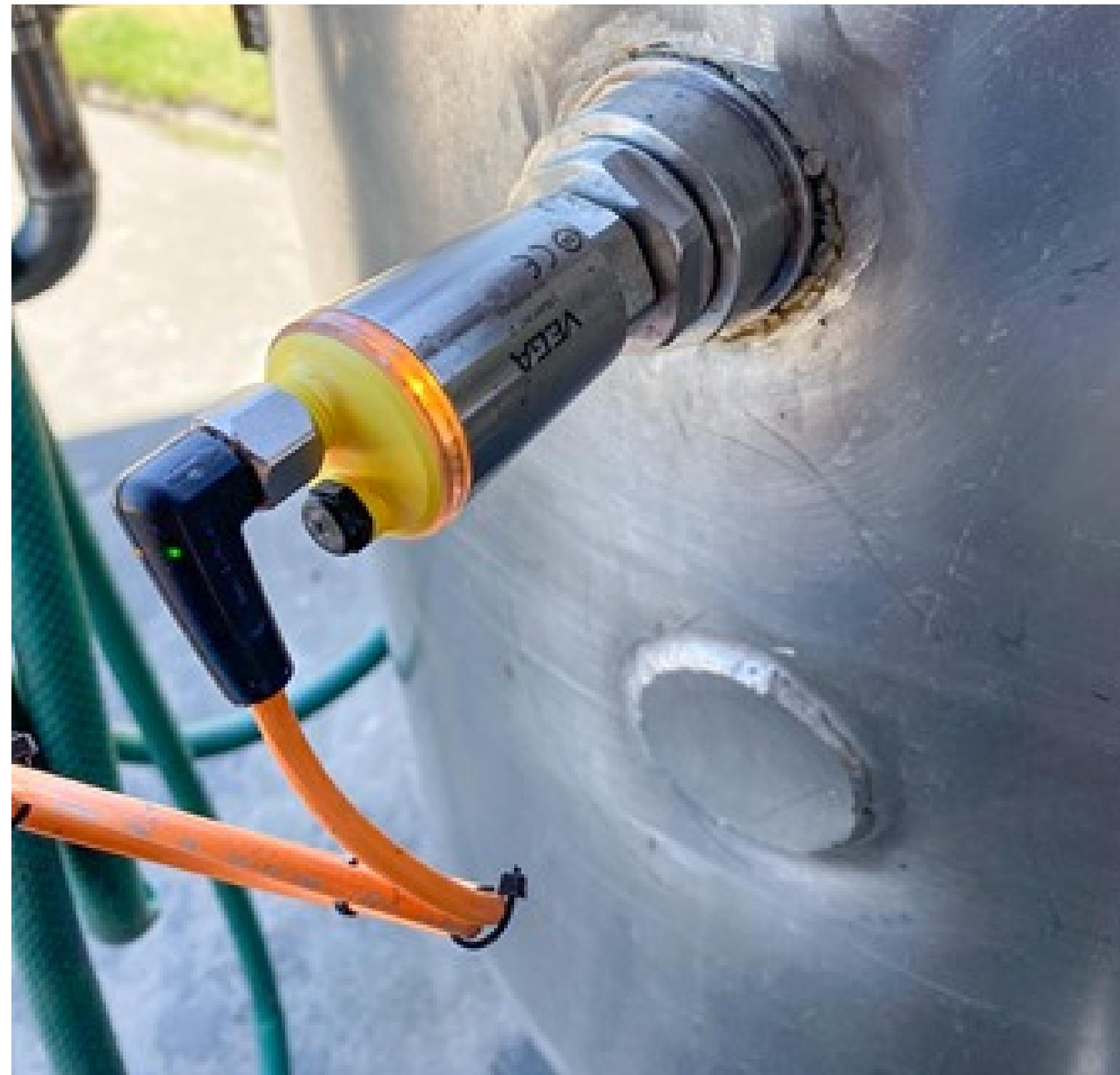
Grâce à sa taille compacte, le VEGAPOINT 21 se monte aussi bien dans des réservoirs et des cuves que dans des conduites étroites.
