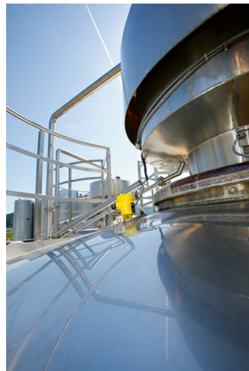
El VEGAPULS 64 mide el nivel de forma fiable en los depósitos de suero lácteo.
