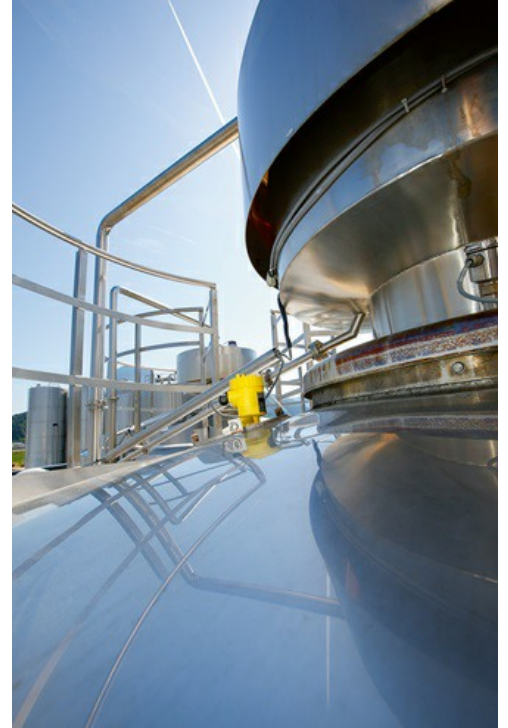
El VEGAPULS 64 mide el nivel de forma fiable en los depósitos de suero lácteo.
