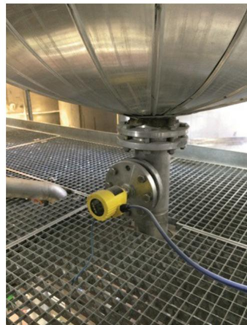
Presión diferencial electrónica de un sensor principal en un depósito de destilación.
