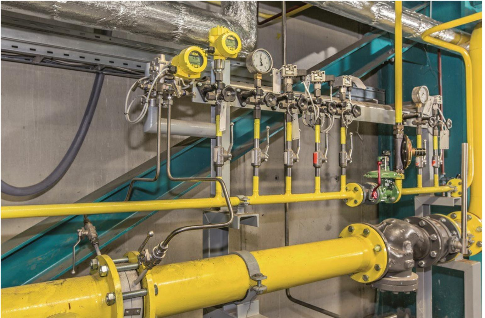
通过测量孔板和传统的压差来测量流量。通过一个额外的传感器来记录静压。
