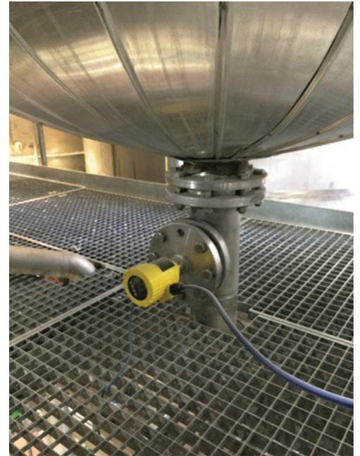
在一个蒸馏锅炉中用于进行电子式压差测量的主传
