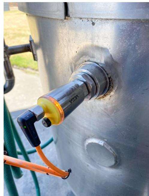
一种用于电容式限位测量的新型VEGA传感器虽然很给力，但尚未推向市场。尽管如此，在正式发布产品之前，有人提出愿意试用。**VEGAPOINT 21** 是一种带有远程开关打开位置的限位开关，用于检测水性液体。在此，传感器和槽罐组成电容器的两个电极。由液位变化而引起的容量变化会转变成一个开关信号。
