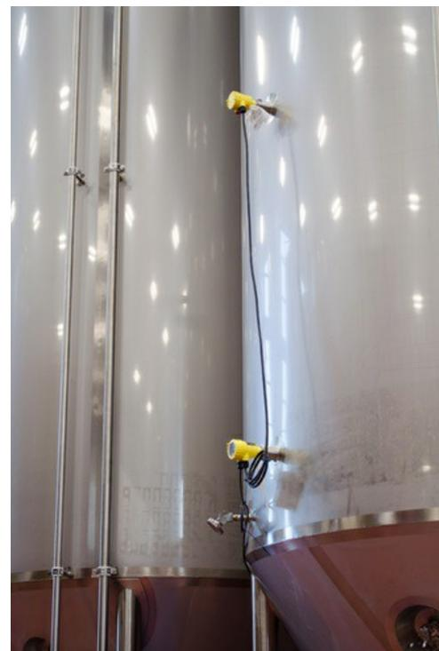
Aperçu virtuel de la cuve : deux capteurs VEGABAR combinent les mesures de pression à deux positions différentes pour calculer une valeur de pression différentielle.
