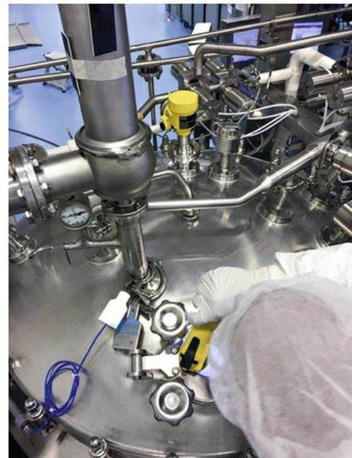
直到最近，这家瑞士公司一直在使用传统的压差系统来测量生物过程。当该公司将 VEGAPULS 64 型 80 GHz 的雷达传感器投入使用，这是第一个非接触式测量系统，安装之快速简便实属罕见。完全不改变现有设备，也无需增加其他配件和连接件。这种高频雷达测量现在能检测体积的测量精度为 $\pm 1$ 毫米。该雷达液位传感器还有另一大优点：如果需要改装，VEGAPULS 64 可以安装在现有的安装插座上，只需要做最小的改动。可在最短的时间内提供可靠的测量值。
