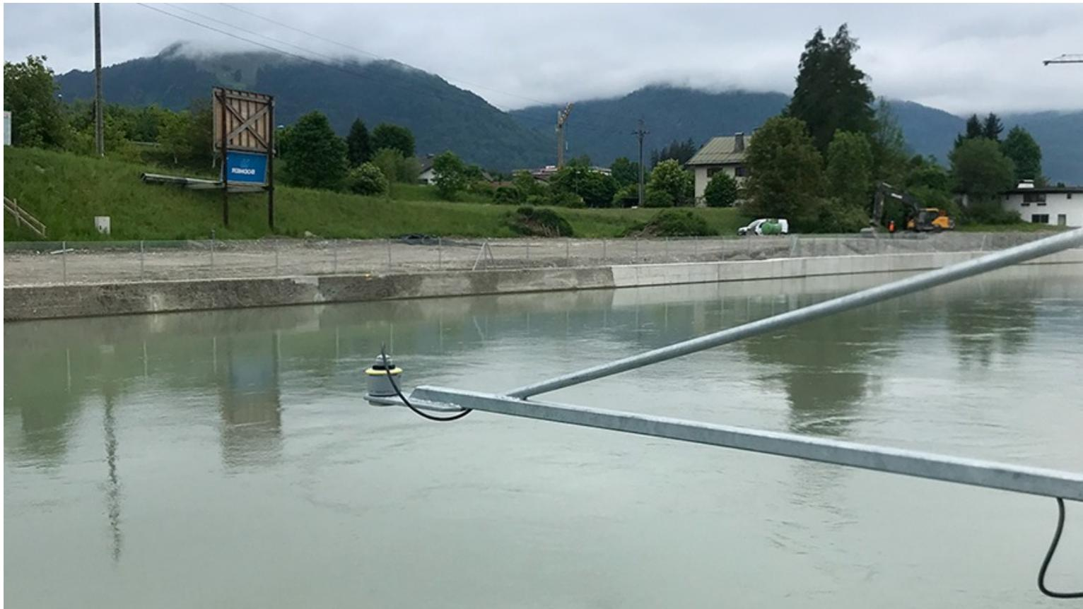
Seit über 15 Jahren arbeitet das Unternehmen bei Fragen rund um die Füllstandmessung mit VEGA zusammen. In den Anfängen suchte man eine Messlösung mit SIL2-Zulassung und stieß auf den **VEGASWING**, der nach wie vor an der Messstelle im Einsatz ist.
