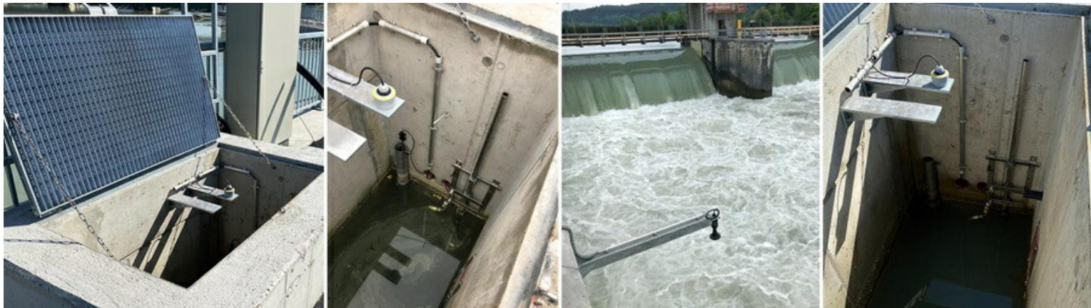
Nonostante i lavori a Kirchbichl non siano ancora conclusi, i sensori hanno già completato i test sul campo. Due sensori della nuova serie **VEGAPULS C 21** rilevano ininterrottamente l'altezza lungo la via d'acqua, e più precisamente nel canale di adduzione, in un punto di misura intermedio, nel pre-bacino, nell'area della turbina e nel pozzo per pompe.
