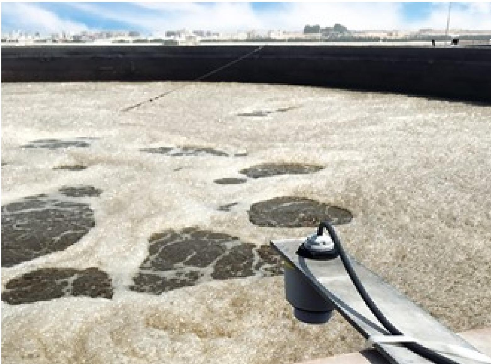
La mousse, les dépôts et la chaleur causaient un encrassement excessif des capteurs de niveau précédents et provoquaient des imprécisions de mesure. Le capteur compact VEGAPULS C 21 à technologie 80 GHz, équipé d'un raccord pour câble fixe, est parfaitement protégé contre la submersion. Depuis le début, il fournit des mesures fiables sans problème.
