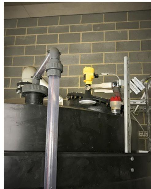
Un capteur radar VEGAPULS 64 monté sur une potence mesure le niveau d'acide chlorhydrique à travers le toit de la cuve de stockage.
