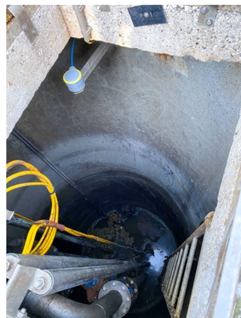
Beengte Verhältnisse im Pumpenschacht in Hart
