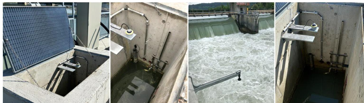
Aunque todavía queda trabajo por hacer en Kirchbichl, los sensores ya han superado su prueba de campo. Dos sensores de la nueva serie **VEGAPULS C 21** monitorizan continuamente el nivel a lo largo de la vía fluvial, es decir, en el canal de entrada, en una medición intermedia, en la cuenca de homogeneización preliminar y en la zona de la turbina y en el pozo de bombeo.
