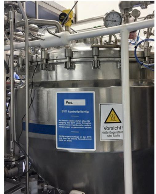
La longitud de onda extremadamente corta de los sensores radar VEGAPULS 64 permite una detección de nivel altamente precisa durante todo el proceso de producción.
