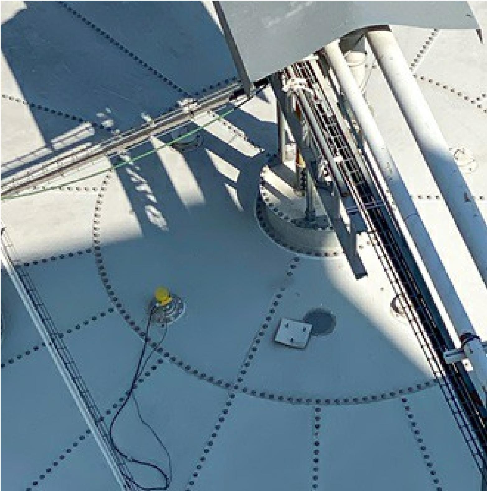
Les obstacles internes et les entretoises représentent un vrai défi pour les mesures à l'intérieur de hauts silos étroits. L'excellente focalisation des capteurs VEGAPULS 69 contribue à séparer le signal de mesure des signaux parasites.
