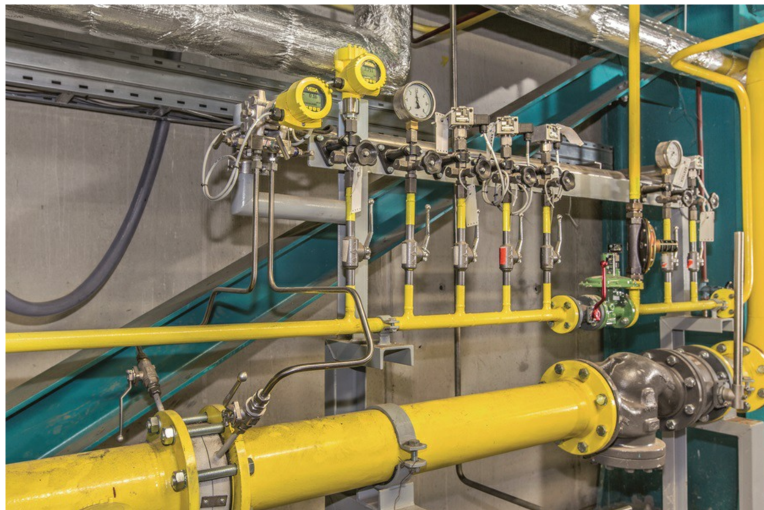
Mesure de débit par plaque à diaphragme et pression différentielle classique. Un capteur supplémentaire mesure la pression statique.
