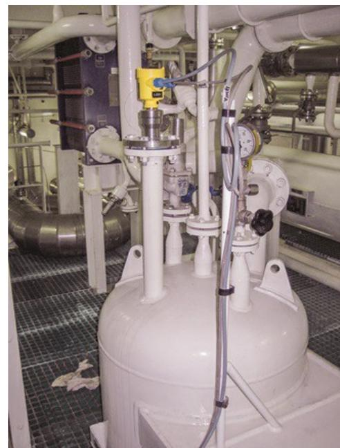
Der VEGAPULS 64 misst den Füllstand in einem Kühlsystem an Bord eines Gastankers.
