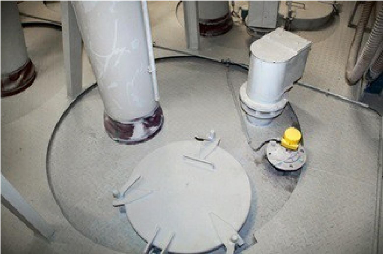
Cette photo montre bien l'étroitesse des silos et la raison pour laquelle le VEGAPULS 69 séduit par son angle d'émission très réduit : il n'y a presque pas de place pour monter l'appareil.
