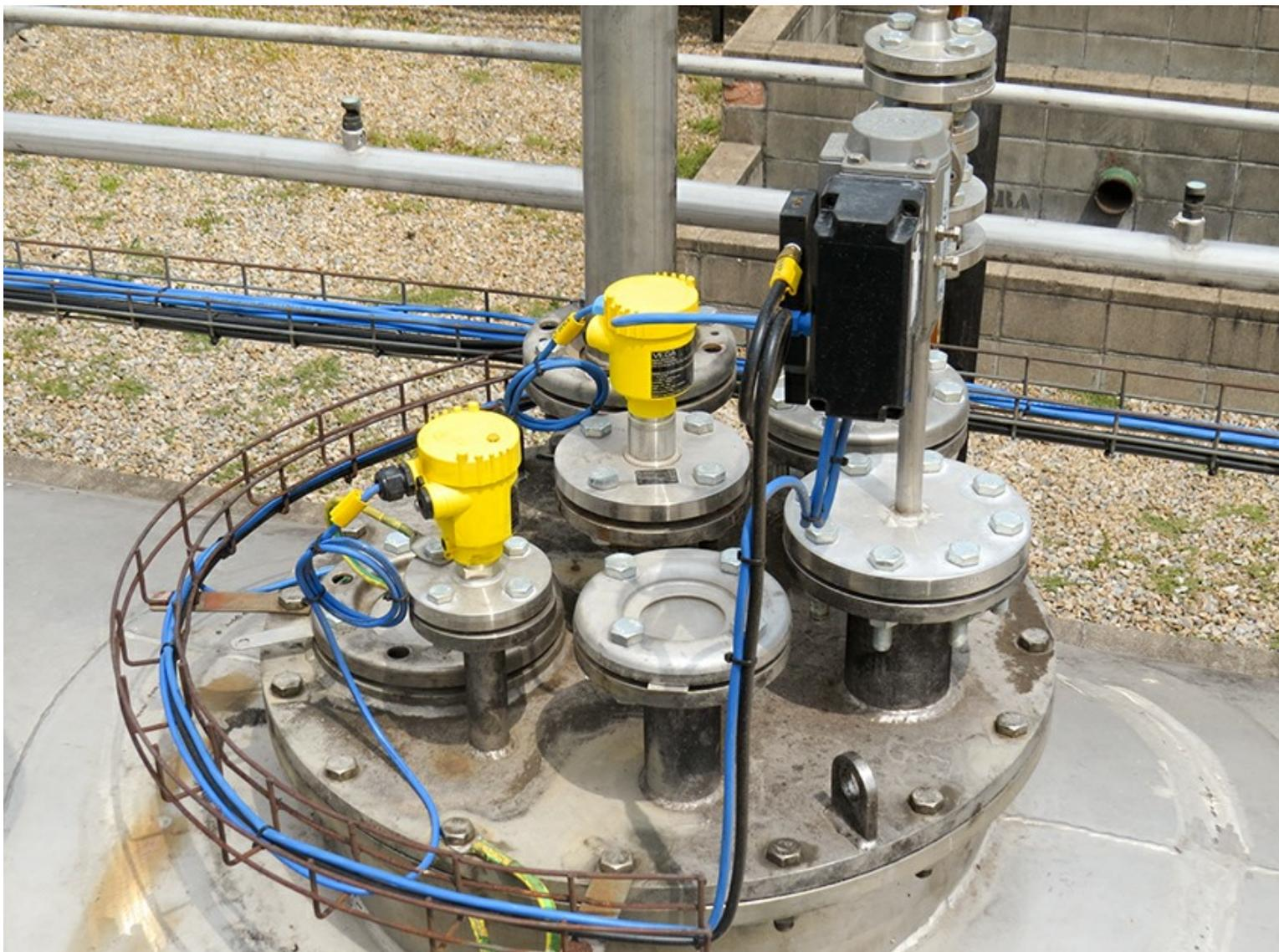
Lo stretto raggio radar del sensore di livello ne consente il montaggio anche in presenza di elementi metallici.
