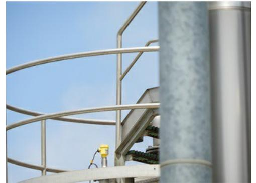
Con l'installazione del VEGAPULS 64 è stato possibile risolvere le incertezze di misura. Il sensore è stato montato semplicemente sui tronchetti preesistenti.
