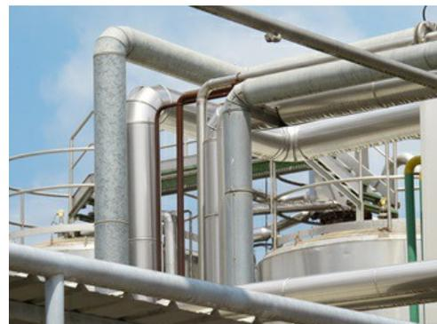
Non ci sono solo numerose tubazioni all'esterno; anche all'interno del reattore serpentine di riscaldamento e altre installazioni influenzano i segnali di misura.
