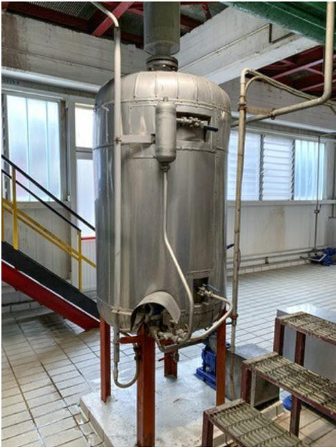
此外，在应用中还存在一个会导致出现测量不确定性的问题，那就是，会在毛细管的管接头上出现细小的**晶体**。简言之，液位测量结果不稳定，且经常不准确。
