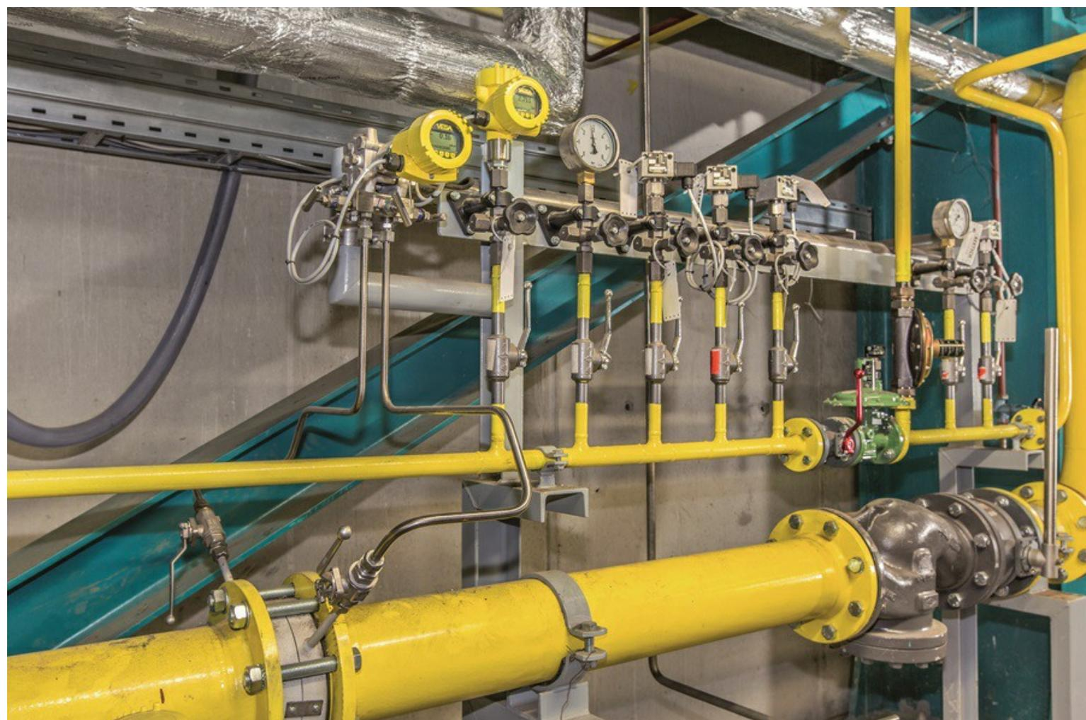
Durchflussmessung über Messblende und klassischen Differenzdruck. Der statische Druck wird über einen zusätzlichen Sensor erfasst.
