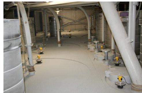
Jedes der Silos verfügt nun über einen VEGAPULS 69, der die bisherige Siloverwiegung ersetzt.
