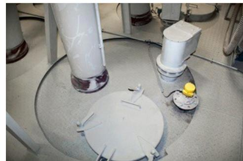
En esta foto se puede ver claramente lo estrechos que son los silos y por qué el VEGAPULS 69 convence con su estrecho ángulo del haz: apenas queda sitio para el montaje del instrumento de medición.
