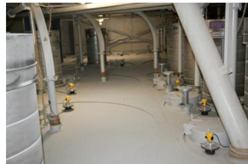
Ciascun silo è munito di un VEGAPULS 69 che sostituisce il precedente dispositivo di pesatura.
