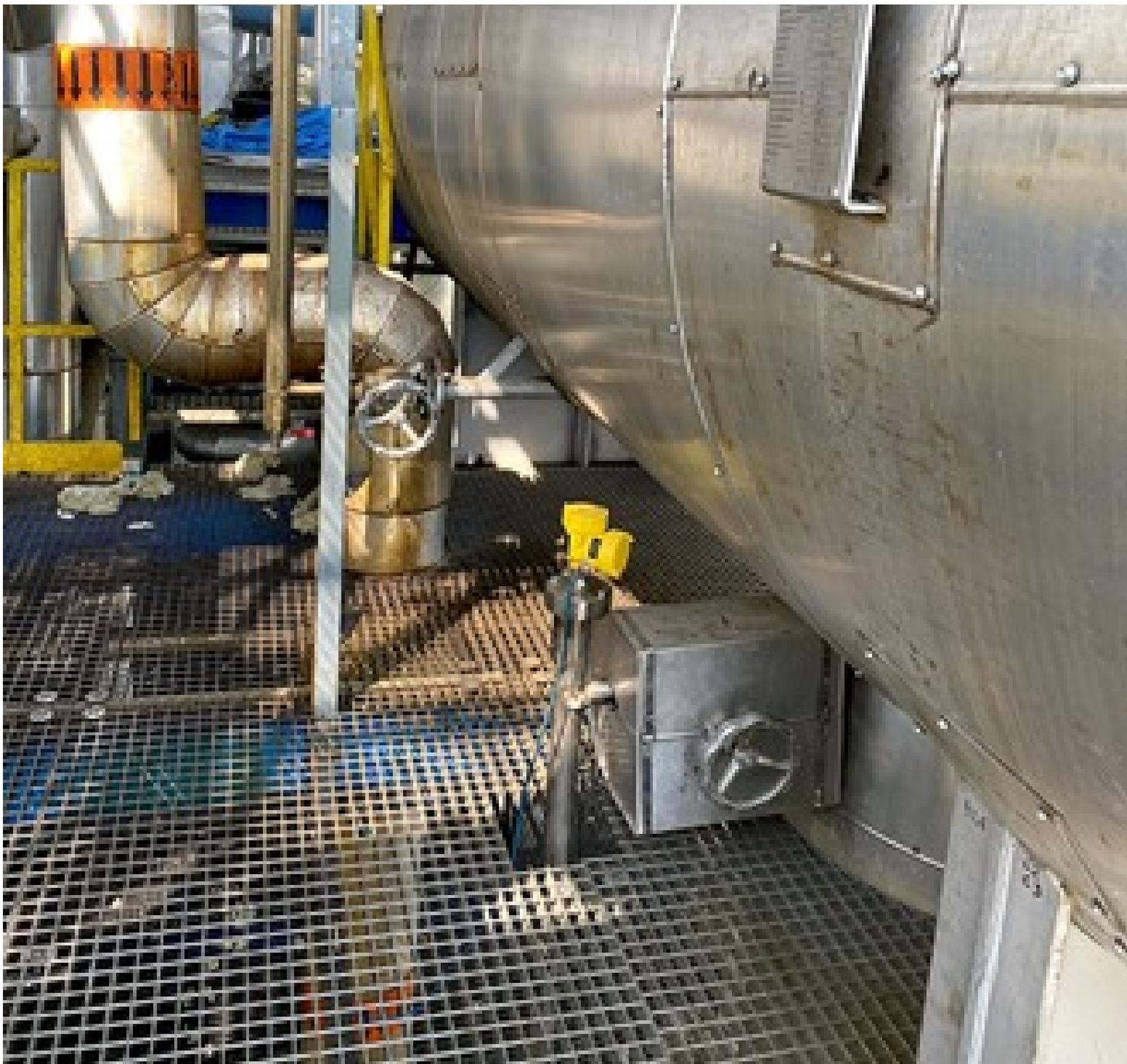
Les capteurs radar à ondes guidées VEGAFLEX 81 mesurent les interfaces dans un séparateur à 3 phases.
