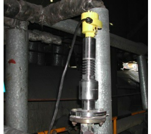
带蒸汽补偿的 VEGAFLEX 86
