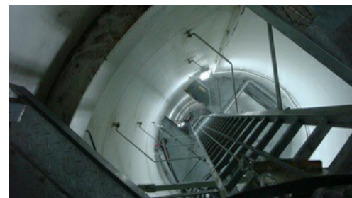
风机塔筒测量
