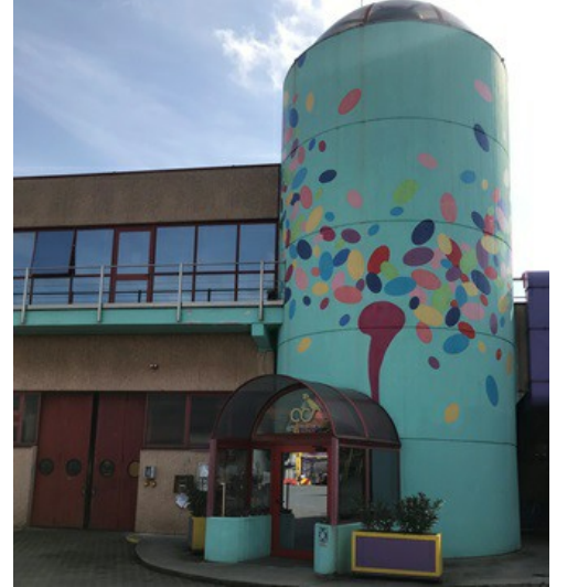
ACS Dobfar'ın Milano yakınlarında bulunan Tribiano'daki merkezi.
