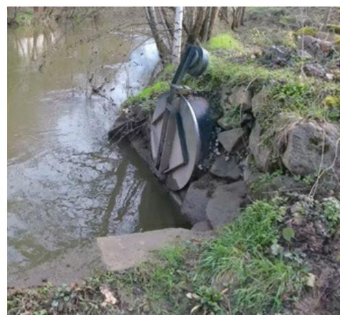
Autre complexité de l'ouvrage : le clapet que l'on voit sur la photo qui provoque un risque d'influence aval du milieu naturel et peut engendrer une surestimation des volumes déversés (et donc, une surestimation des investissements nécessaires à la réduction des déversements).
